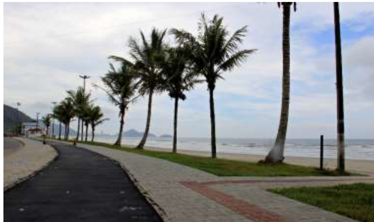
Figura 25 - Obras do projeto Orla em execução, Praia Central. Fonte: Secretaria da Comunicação Social, 2014.
