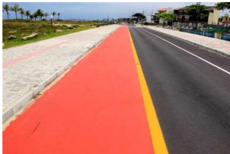
Figura 26 - Obras do projeto Orla em execução, Brejatuba. Fonte: Secretaria da Comunicação Social, 2014.
